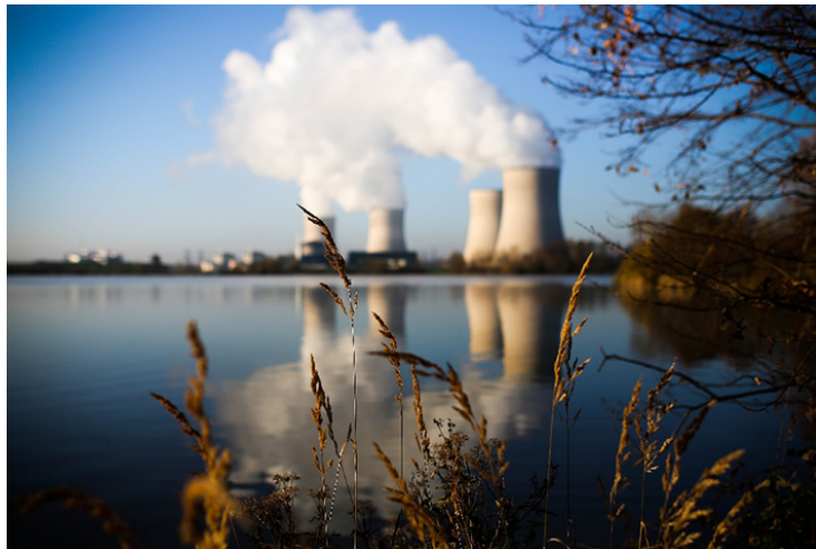
Figure 1: Centrale de Saint-Laurent-des-Eaux dans le Loir-et-Cher fonctionnant avec deux réacteurs d'une puissance unitaire de 900 MW
